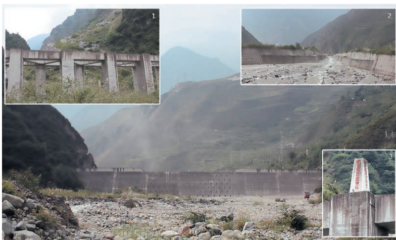
Противоселевая монолитная плотина. На врезках: 1 — верхняя плотина и оползень над ней, 2 — направляющий лоток, 3 — опорный знак (фото авторов)
