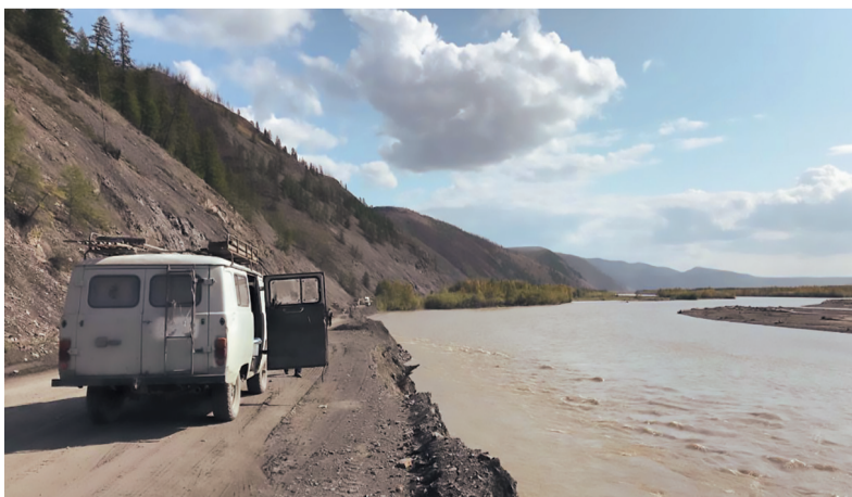
Остановка по маршруту: впереди размыло дорогу
