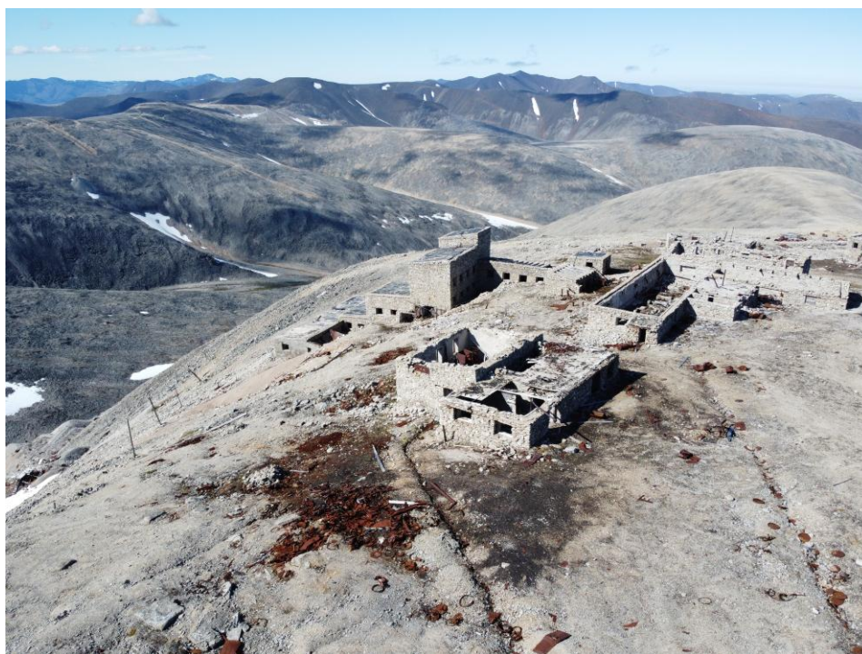
Рис.4. Обогащительная фабрика в Восточном, окруженная подсобными мастерскими. На заднем плане — горы северного окончания Шелагского хребта — самая северная часть материковой Чукотки. Фото Ф.А. Романенко, 2020
